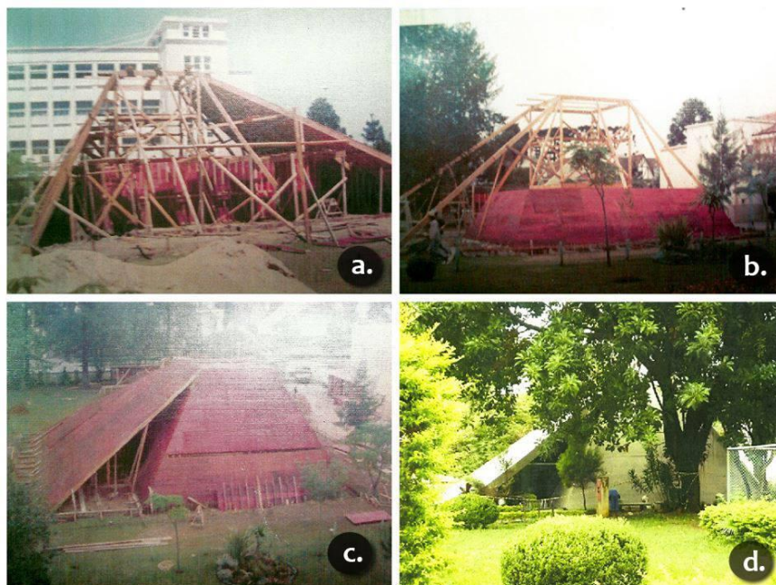
Figura 11: Construção do Planetário. (Figuras a, b, c década de 1970) e (d, 2010). Fonte: Acervo CM-CEP.
